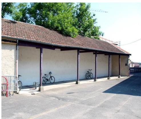
L'entreprise Oudin sera présente en juillet pour changer la toiture et renforcer la structure du préau-abri communal se trouvant en arrière du bloc communal, à proximité des garages communaux. Ainsi, pour un montant de 4 759,70 € HT, seront réalisés les travaux suivants : renforcement de la charpente avec pose de panne, dépose de tuiles et lattes, mise en place de tuiles « terre cuite » losangées, de planches de rive avec bandeau « zinc plomb » et scellement de tuiles losangées sur le mur.
